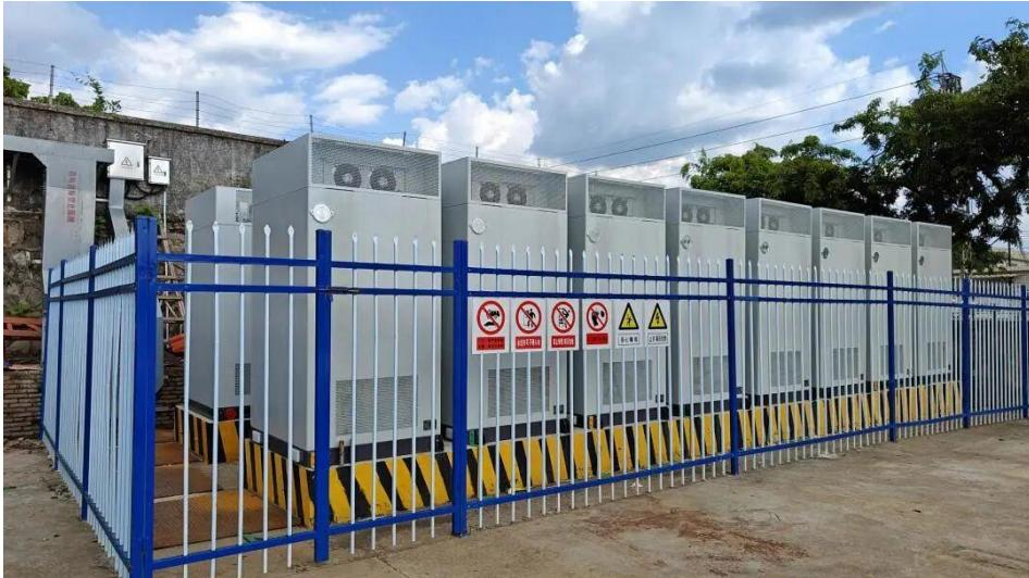
该储能电站由16台241kWh的一体式液冷储能柜背靠背排成两排并柜组成，总容量为3.856MWh。模块化储能系统设计，占
