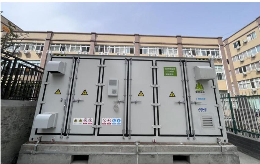
该储能电站通过“削峰填谷”+“两充两放”的运营模式参加四川省电力交易市场，在电力负荷供应宽裕的夜间谷段以及中午平段为储能电站进行充电，在电力负荷供应紧张的“峰及尖峰段”时期进行放电。可实现用户全年减少“峰及尖峰段”用电量约190万度。
