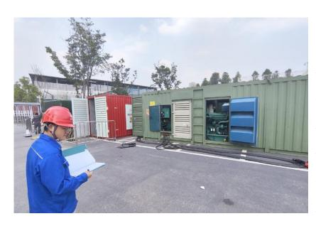
为缓解高峰时期配电 网局部供电压力,国网成 都供电公司使用发电机组 提供支撑。8月21日,成 都锦江区晨辉路公园内, 供电人员将一台发电机组 接入10千伏望才线金象五 组环网柜,并入配网发电。
