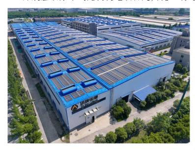
安装完成后,屋顶相当于建立了 一个隔热保温层,可降低车间温 度3-4℃,提升了员工工作舒适 度。同时,分布式光伏电站将利 用太阳能转化为电能,为企业提 供清洁、可再生的能源。这种分 布式光伏发电方式有助于减少碳 排放,促进可持续发展,也能够
