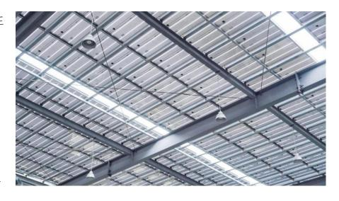
米的"低碳智造"智慧工厂顶部安装了碲化镉光伏组件。近期屋顶光伏发电量都突破了4000接近5000度/天,尤其是中午12点至下午3点时段,峰值发电功率皆超过600kW。高温意味着充足的光照资源,自发自用,余电上网,既保证了重要项目生产正常运转,同时也缓解了供电压力起到了积极的作用。
