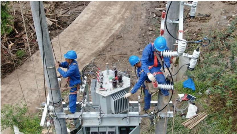
柜……各项工作迅速有条不紊地开展起来。有的队员在电杆上固定变压器台架，有的队员在电杆下面负责安全监护，还有的队员在电杆旁挖沟为安装接地桩
