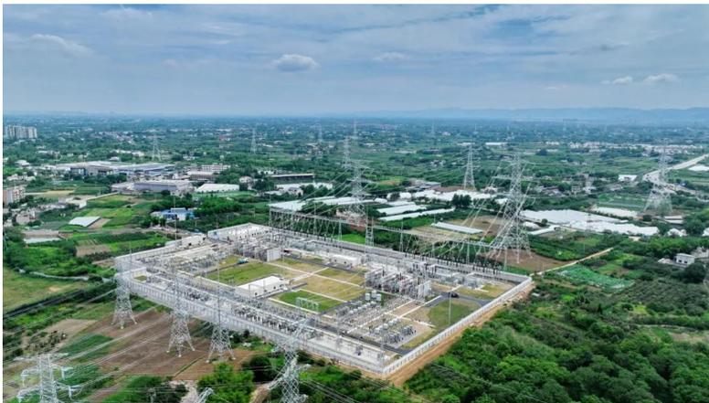
500千伏十陵输变电工程是四川电网2024年迎峰度夏重点工程。工程新建十陵500千伏变电站，新装主变压器2台，新增变电容量240万千瓦安，新建4回500千伏输电线路。待建设中的川渝1000千伏特高压工程投运后，十陵500千伏变电站将东联成都东1000千伏变电站，成为成都电网承接川渝特高压工程的关键接入点，有力提升成都电网供电能力。
