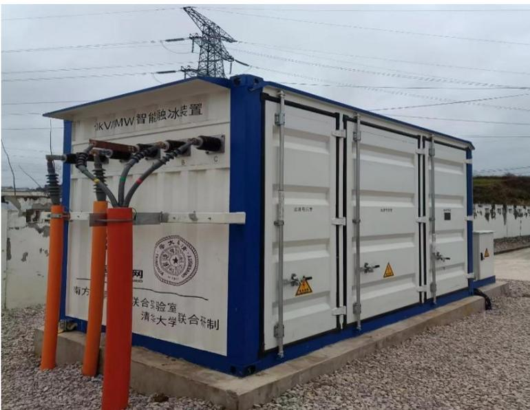
新型IGCT-CSC直流融冰装置由清华大学电机系、清华四川能源互联网研究院直流研究所、贵州电网电科院、北京四方继保自动化股份有限公司联合研制，为世界首套IGCT-CSC直流融冰装置。与晶闸管半控电流源和IGBT全控电压源方案相比，
