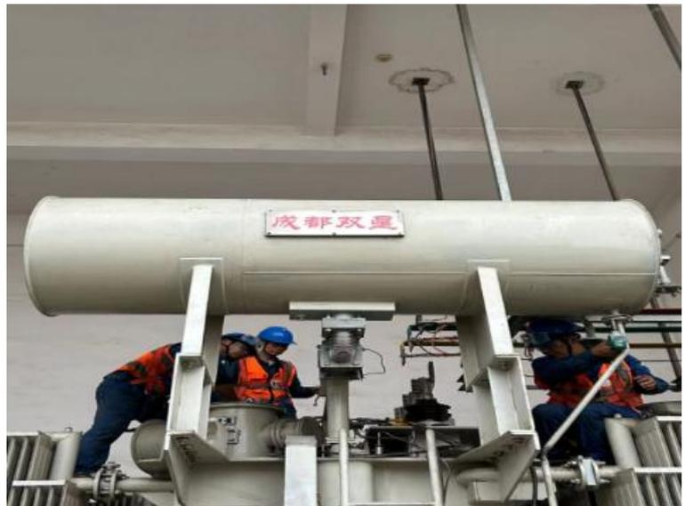
提供优质、充足的原材料，是建圈强链”行动的有力支撑。本次工程为7台35kV变压器现场吊罩大修，主要检查变压器内部绕组、引线、铁芯、绝缘支架、夹件，同时过滤变压器油油箱防腐处理、更换易损部件（密封垫、阀门），检修组部件及试验，该工程对承包方施工规范、专业人员配备质量标准、服务水平等有严苛的审核和筛选，经过多轮评标议标程序，成都双星变压器有限公司脱颖而出，成功入围供应商。
