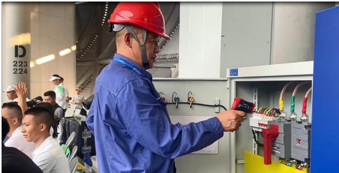
“大运会开幕式启动后，我们将每15分钟开展一次设备检测。”7月28日，成都第31届世界大学生夏季运动会开幕式前1小时，国网成都市高新供电公司保电队员刘新远正在对东安湖体育公园主体育场场馆进行开幕式前最后一次配电设备检查，逐一开展红外测温、负荷电流测试及媒体看台器检测，确保开幕式保供电万无一失。
