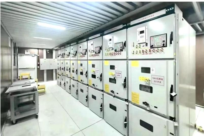
本次增容工程新增110/10--40000kVA主变1台、10kV出线4回、10kV同站并线2回，充分利用了预制舱模块化变电站占地面积小、施工作业少、建设速度快等优势，在原站既有空间内，实现主变及10kV预制舱式组合设备的
