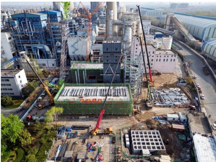
焦亚硫酸钠车间、吸附再生装置基础、喷淋冷却塔基础、循环水建构物烟风道支架、废水处理设施、循环水处理车间、载冷剂溶液池等施工。该项目地处中国华东地区、山东东南部、黄海西岸。冬季寒冷干燥，雨雪稀少。
